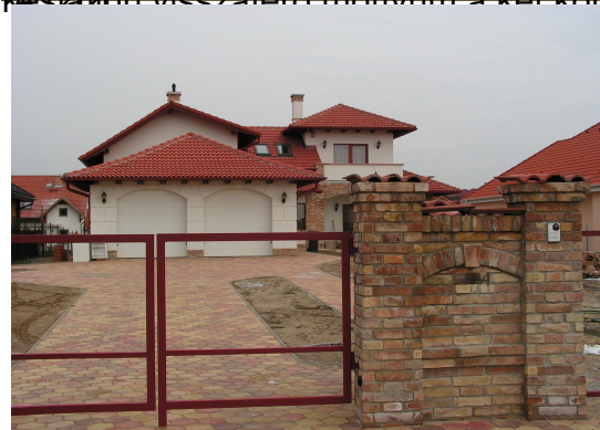
Az elkészült ház a szerkezetkész kerítéssel.
