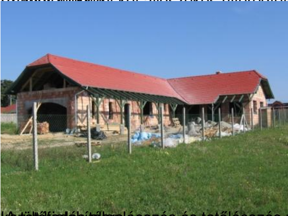
A tetőfedés és a falazás után piros színű hófarkú utánzatú betoncsereppel
