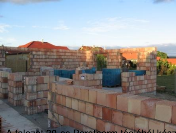
A falazat 30-es Porotherm téglából készült
