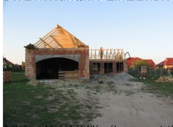
A tető szerkezet két állásos nyeregtető 7,5 x 15 cm-es szarufákkal és 15 x 15 cm-es
