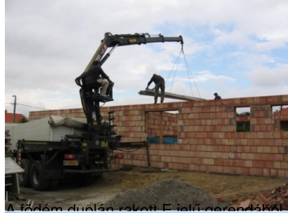
A földem dupla rétegű E jelű gerendából készült, beton béléslemmel.
