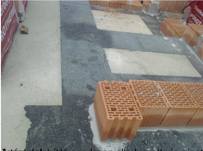
Aktív felületre gondosan elhelyezett vízszintes elő lemez készül, a toldásoknál megfelelően
