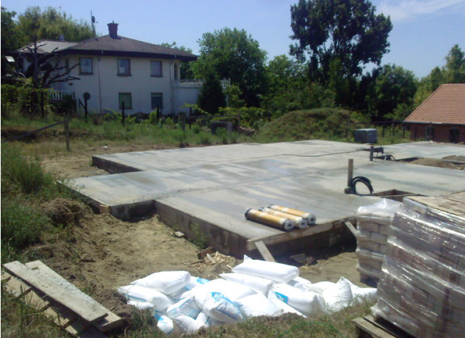
Az alapítványok földmelletti részének és a tartók falakjainak földdel való feltöltése történt meg.
