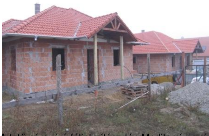
A tető nézvére fóliatorítás után Mediterrán stílművet betoncsereppel került elkészítés.
