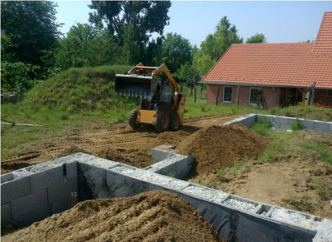
Az alapítványok földmelletti részének és a tartók falakjainak földdel való feltöltése történt meg.
