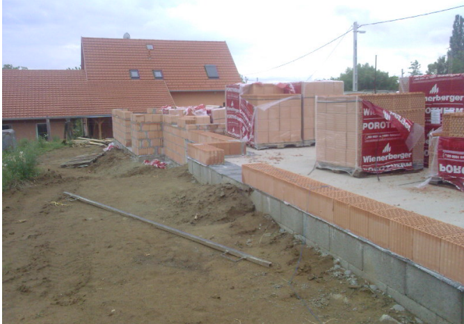
Készült téglák elhelyezése után következik a falazás. A falak Porotherm rendszerű téglából
