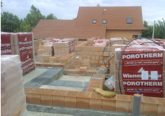
Készült téglák elhelyezése után következik a falazás. A falak Porotherm rendszerű téglából
