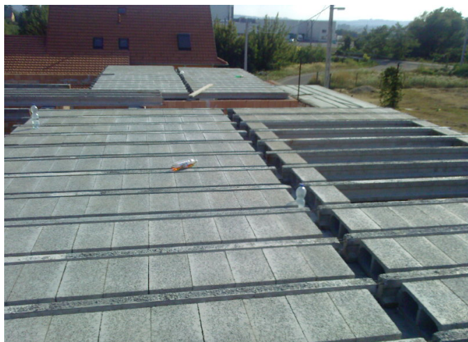
A földem F ielű gerenda földem beton hálószerkezetekkel
